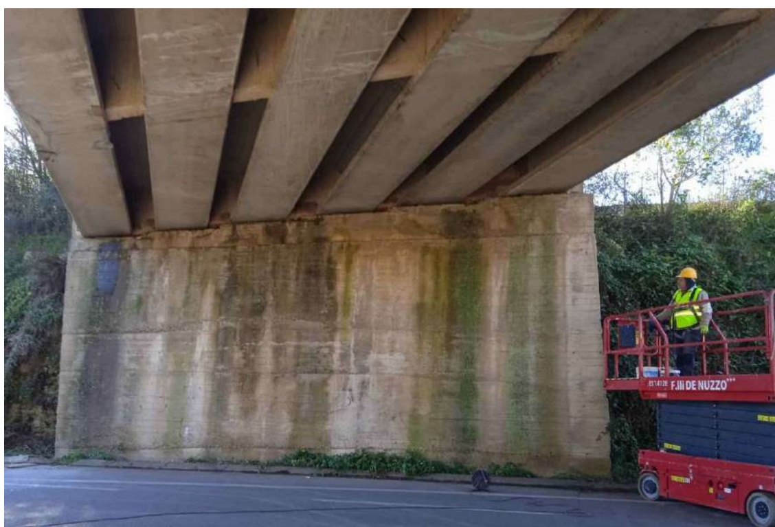
63. Messa in sicurezza opere d'arte lungo le SS.PP. 367, 210 e 335, 2022 – Lecce (LE)
