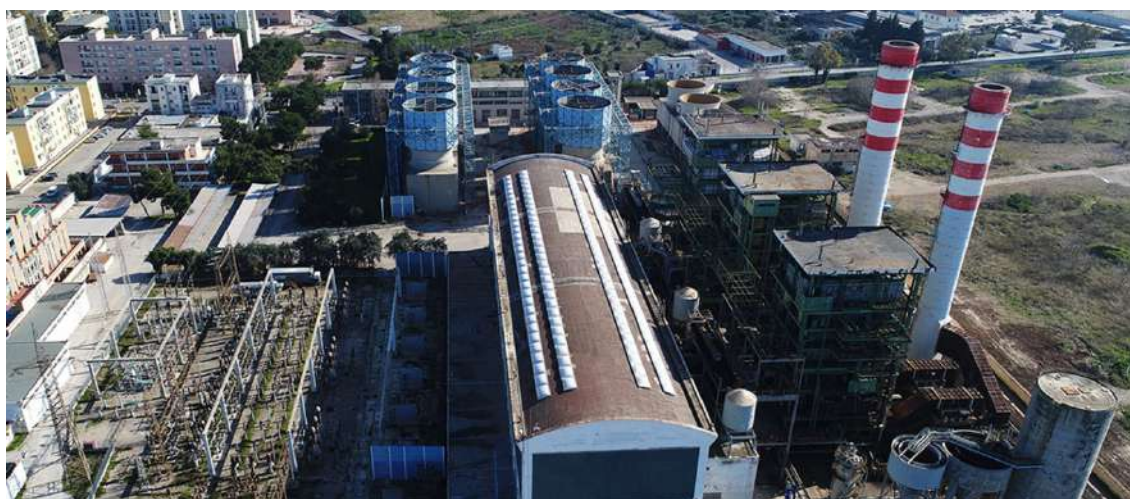
56. Ristrutturazione Officine Centrale termoelettrica ENEL S.p.A., 2019 – via Buozzi Bari (BA)
