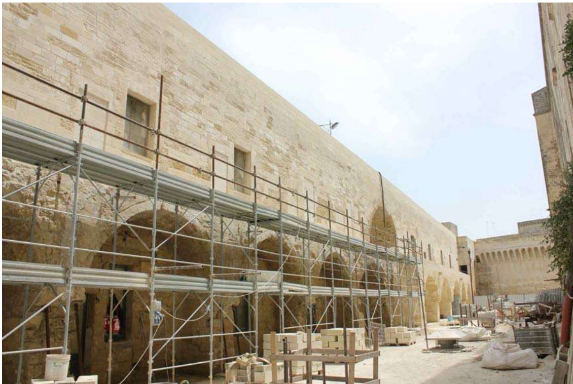
27. Consolidamento Castello Carlo V, 2019 – Lecce (LE)
