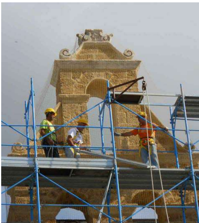
21. Restauro Chiesa dell'Immacolata, 2013 – Mesagne (BR)
