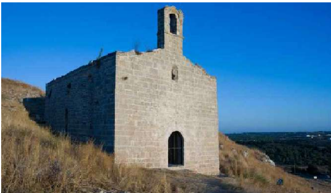
32. Restauro e consolidamento Chiesa abbaziale San Mauro, 2014 – Sannicola (LE)
