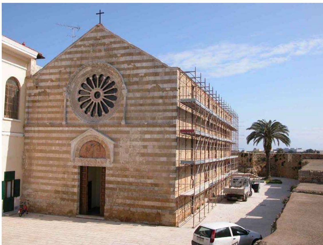
30. Restauro Chiesa del Cristo, 1992 – Brindisi (BR)
