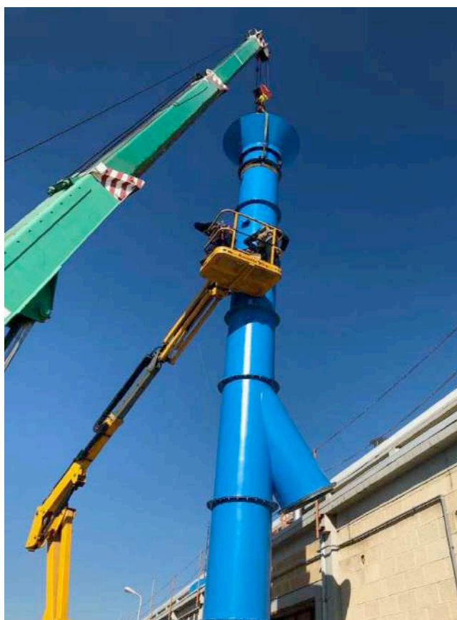
5. Montaggio camino estrazione fumi, 2018 – Avio Aero (BR)
