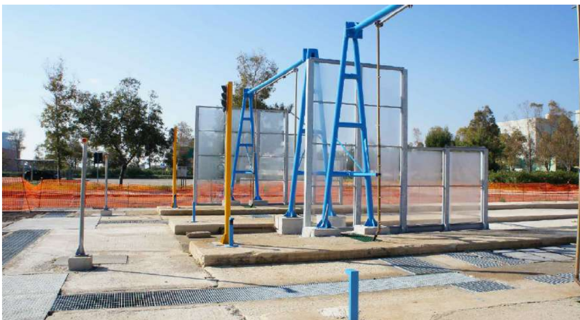
6. Lavaggio camion, 2015 - Centrale ENEL (BR)
