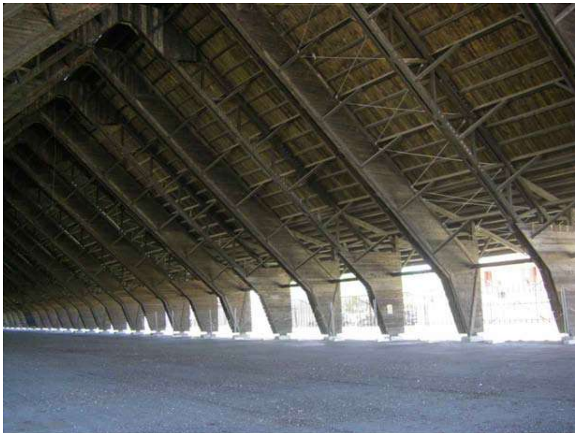
47. Ristrutturazione copertura in legno Capannone ex Montecatini, 1998 – Brindisi (BR)
