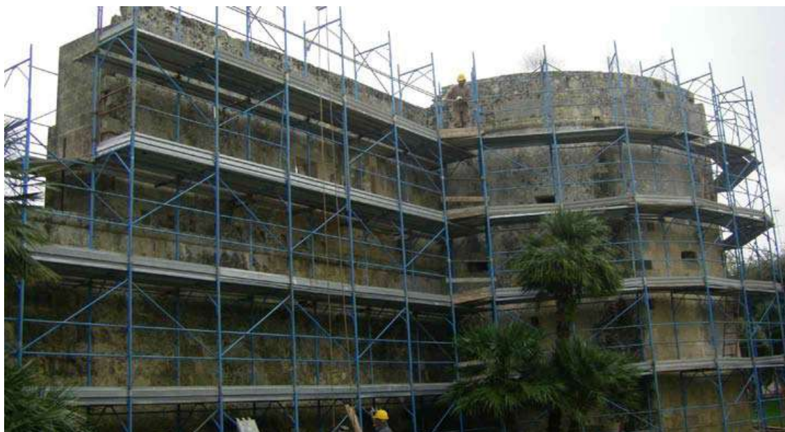
53. Consolidamento facciate Castello Aragonese, 2000 – Palmariggi (LE)
