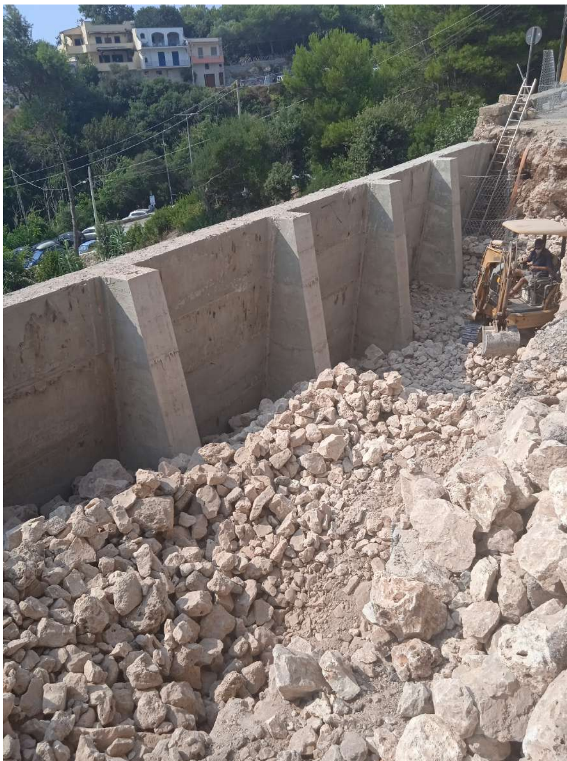
57. Consolidamento opere d'arte, 2022 – località Marina di Marittima Diso (LE)
