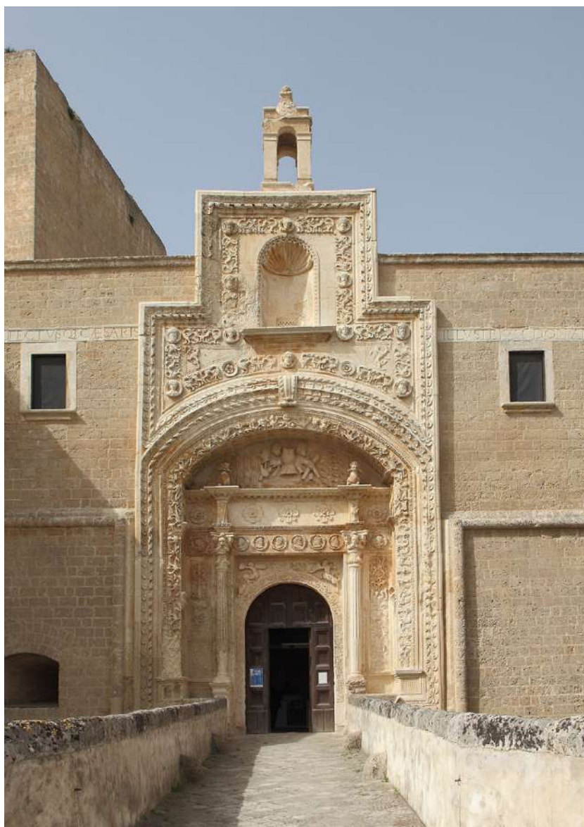
33. Restauro delle mura di facciata, 2017 - Castello di Copertino (LE)
