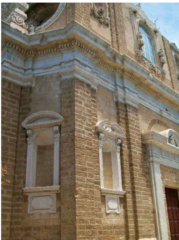
20. Restauro Chiesa dell'Annunziata, 2012 – Mesagne (BR)
